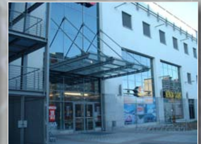
Üvegezett előtető az oldalbejáratoknál
