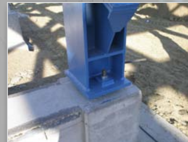
Állítható oszloplerőgázítás
