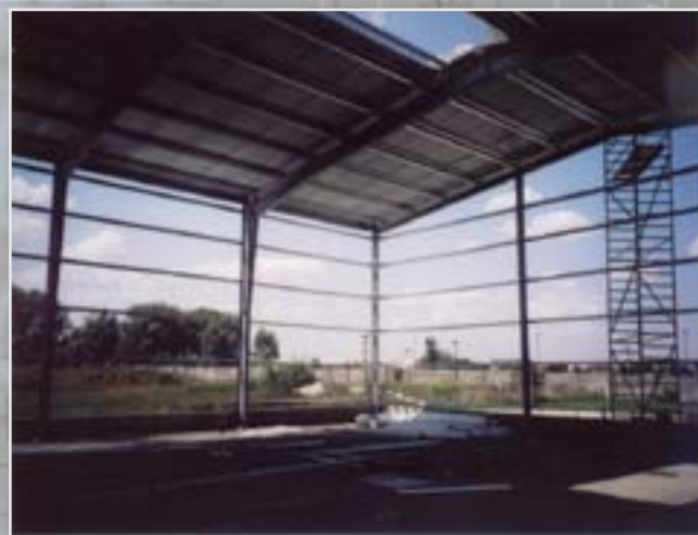
Csarnok szerelés közben
