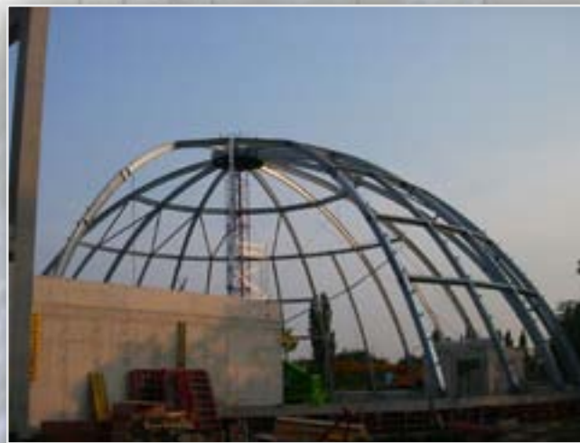
A szerkezet szerelés közben
