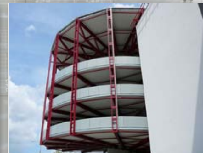
Spirálrámpa alsó földemlemez burkolat
