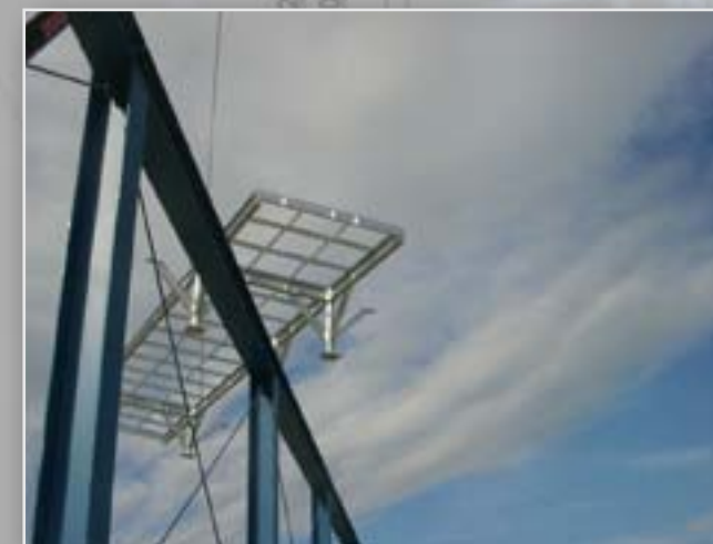
Antennatartó emelés közben
