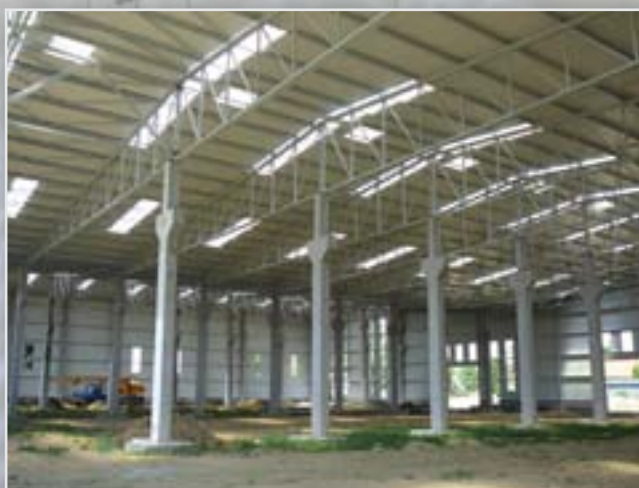
Vasbeton oszlopok, rácsos főtartók
