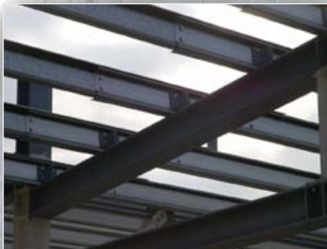
Hidegen hajlított profilok átlapolása
