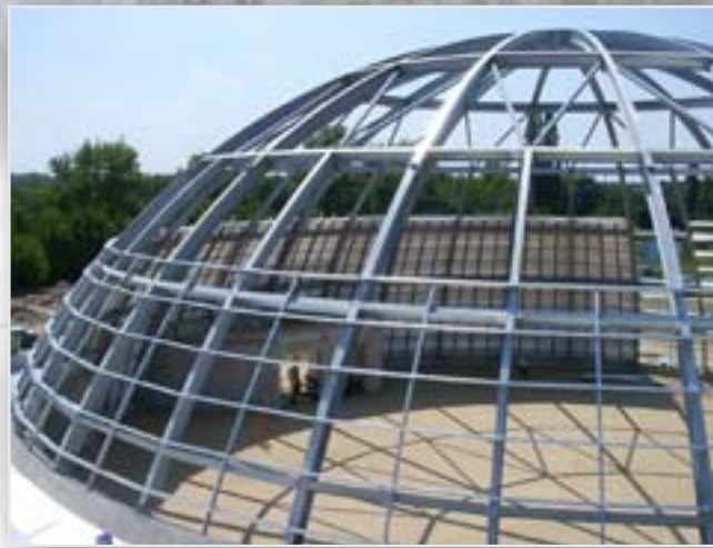
A félgömb acél vázszerkezet
