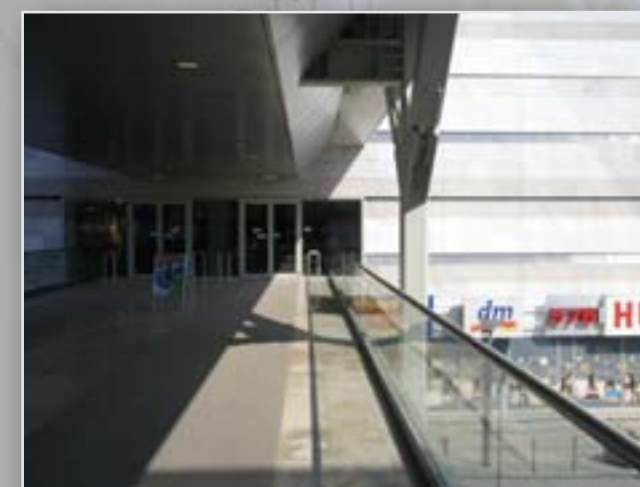
Híd alsó szintje rozsdamentes ütközésvédőkkel
