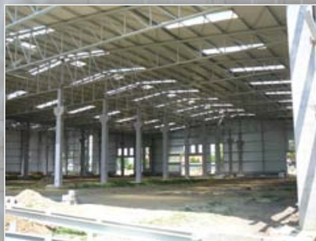
Vasbeton oszlopok, rácsos főtartók
