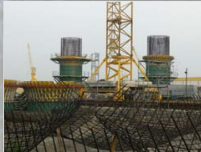
Az előszerelt zsaluzatok beöntés előtt
