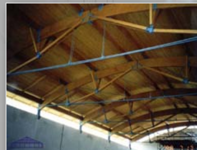
Ragasztottfa- acél tetőszerkezet
