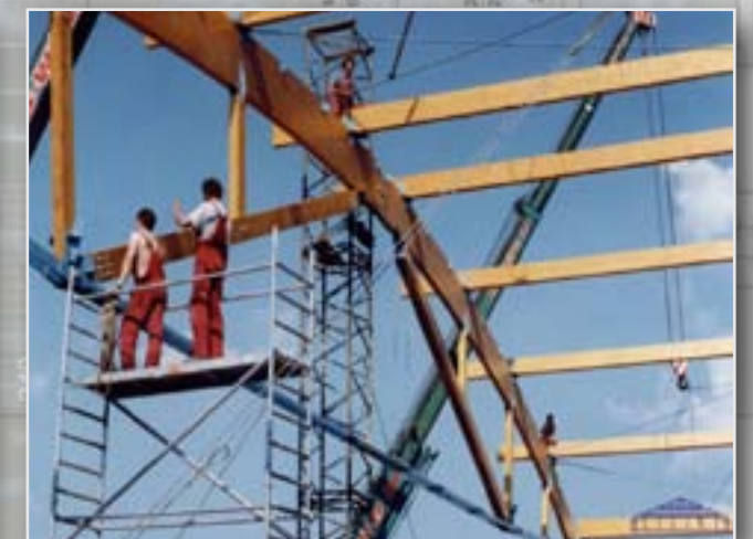
Tetőszerkezet szerelés közben
