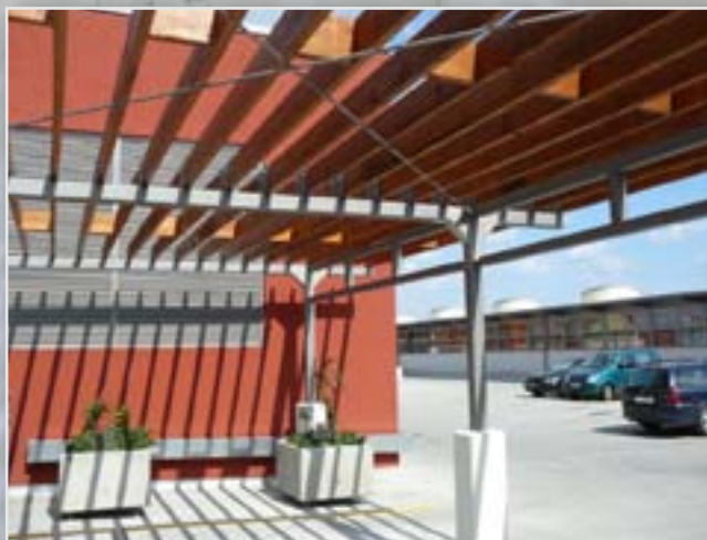
Acél és fa pergola szerkezet a tetőn
