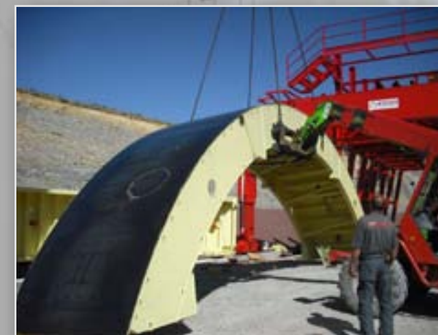
Panelek előszerelése
