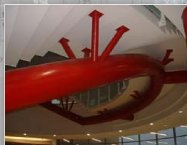
50cm átmérőjű, 16mm vastag cső
