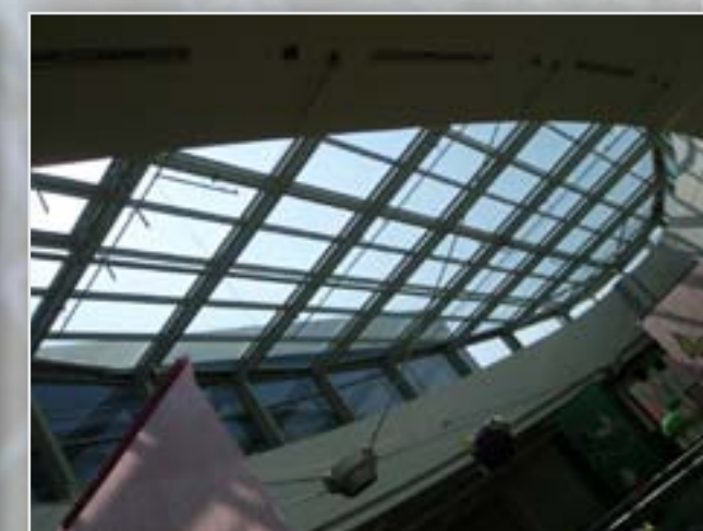
Ellipszis alakú üveghordó acélszerkezet
