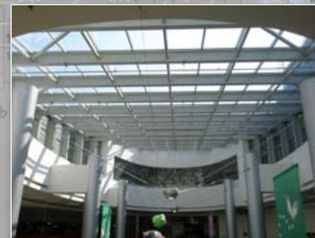
Ellipszis alakú üveghordó acélszerkezet
