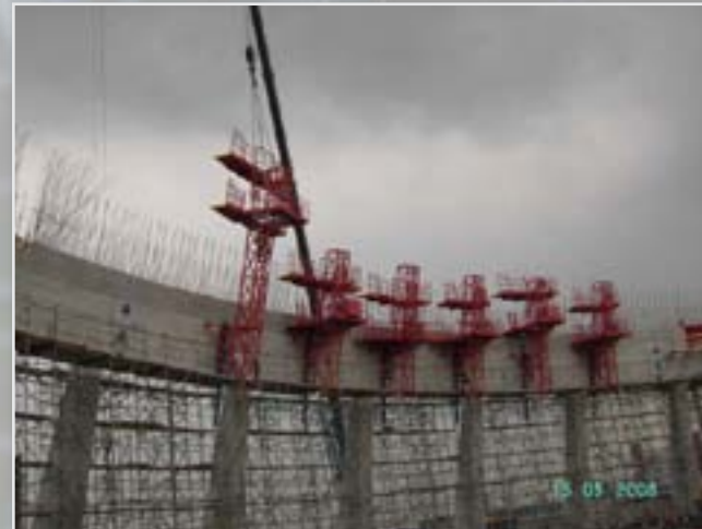
A mozgatótornyok emelése
