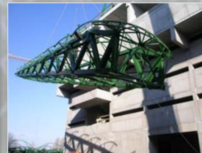
A rácsostartók egyben történő beemelése
