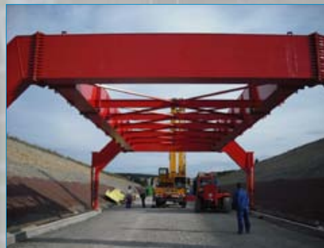
Vázszerkezet hegesztett doboz-tartókkal
