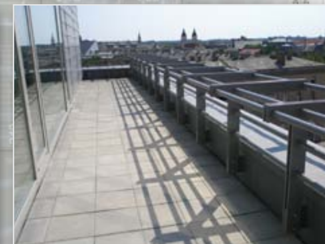
Tetőn lévő korlátok
