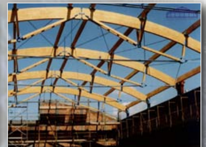
Tetőszerkezet szerelés közben
