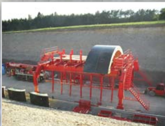
A zsaluzópanelek szerelés közben
