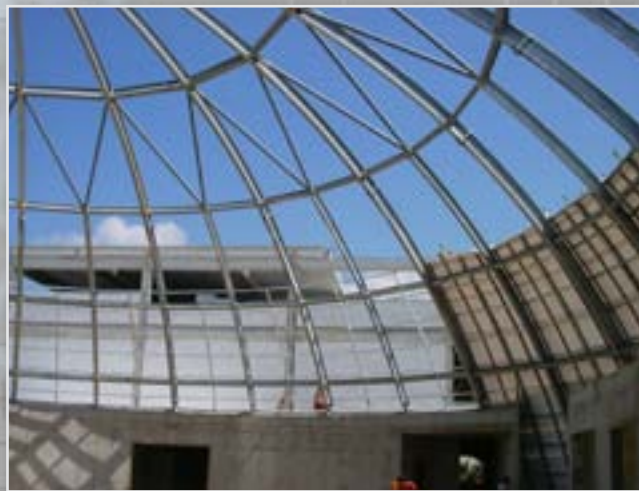
Acélszerkezet burkolat váza belülről
