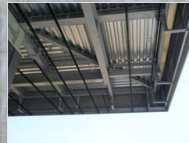
Tűzhorganyzott acélszerkezet lemezfedéssel
