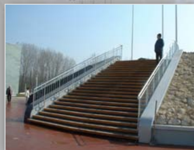
Ragasztottfa lépcsőszerkezet
