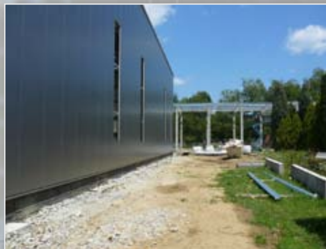
Szendvicspanel-burkolat szerelés közben
