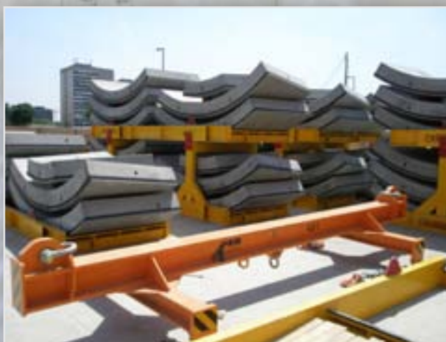
Betonszegmensekkel rakott keretek
