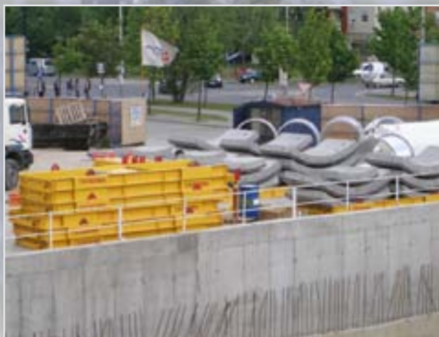
Emelőkeretek részben betonelemekkel
