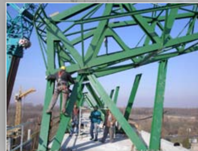
Rácsostartók szerelése alpin-technológiával
