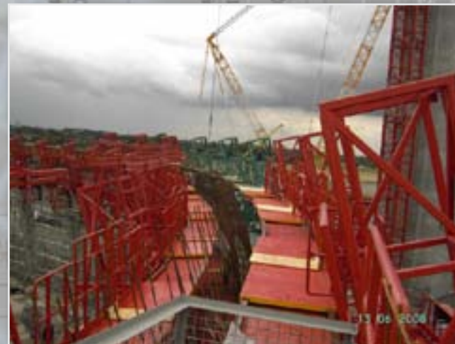
Acélplatformok a magasban
