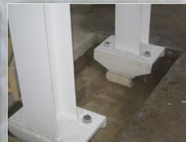
Oszlopok bebetonozott lehorgonyzása
